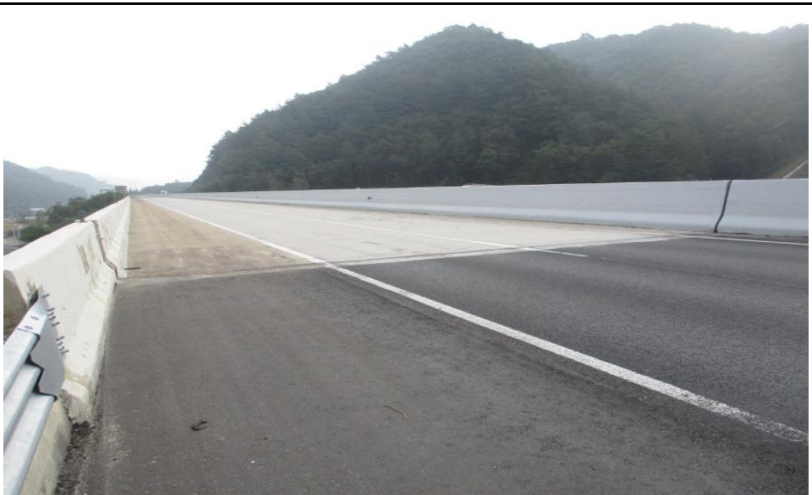
교량 상부 전경
